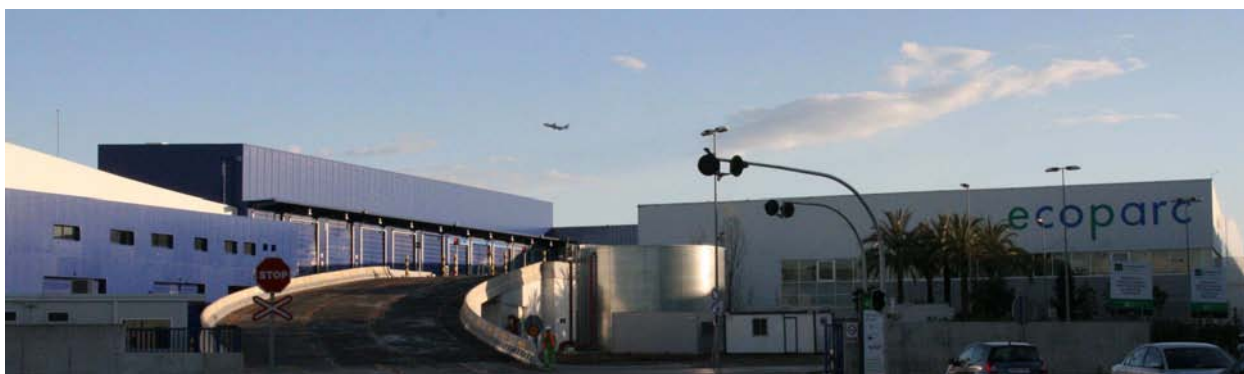
Figura 6 : Impianto di Ecoparc 1
