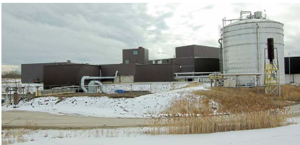
Figura 1: Impianto di Dufferin
